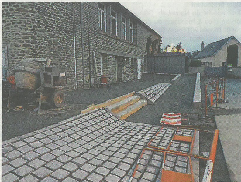
Des travaux sont en cours dans la commune.
